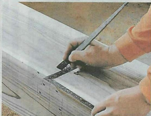
適材適所を考え、墨付けをする大工さん。伝統構法では木の特性を見分ける目が求められる
